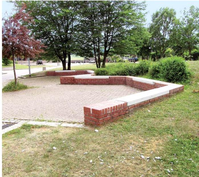
**Die Sitzgelegenheiten** vor der Großsporthalle wurden in den Schulferien von Mitarbeitern des Städtischen Bauhofs in Zusammenarbeit mit dem Tiefbauamt erneuert beziehungsweise die verrotteten Holzplatten durch extra dafür hergestellte Betonplatten ersetzt. Bild: Stadt Engen
